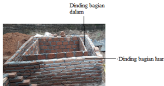
Gambar 30. Penampakan dinding ZECC bagian dalam dan luar
