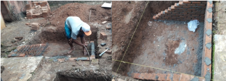
Gambar 29. Penataan batu bata sebagai dinding ZECC
