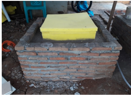
Gambar 37. ZECC sebagai penyimpanan dingin tanpa menggunakan energi listrik
