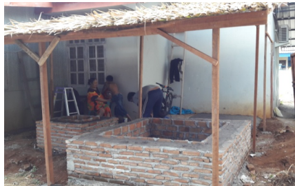
Gambar 32. ZECC dengan atap daun nipah
